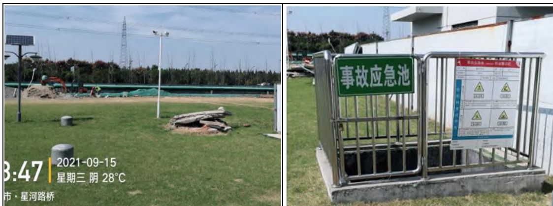
图 5.5-2 事故应急池建设情况
